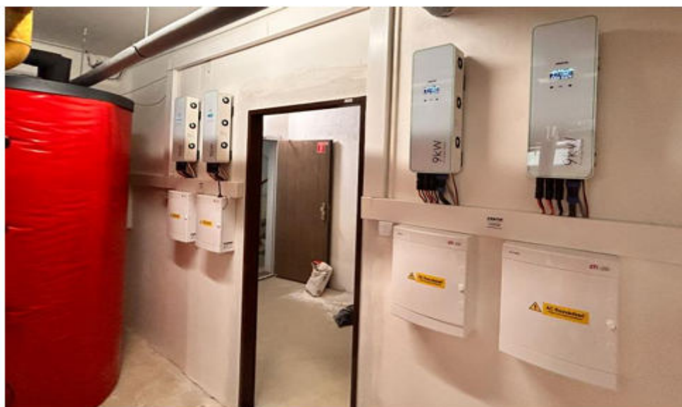
Elektroinstalace 4 jednotek ohřevu vody v bytovém domě
